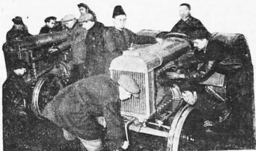
Автодорожцы-общественники гаража № 6 Москомтранса ремонтируют два трактора к весенней посевной кампании. Ударная работа была выполнена раньше срока и была закончена первой в Москве.
